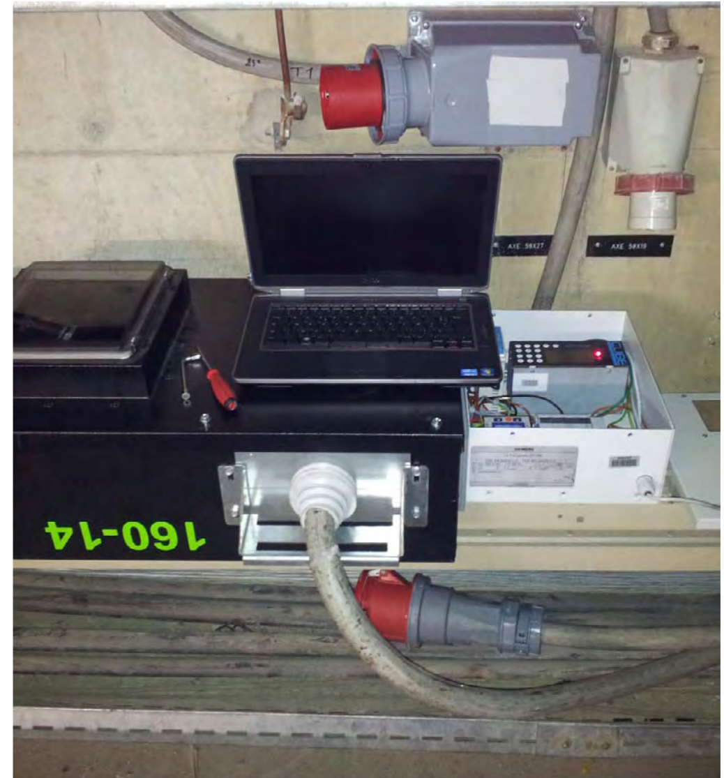
Exemple d'implantation de KEOPS INFRRA sur un rail d'alimentation plafond
