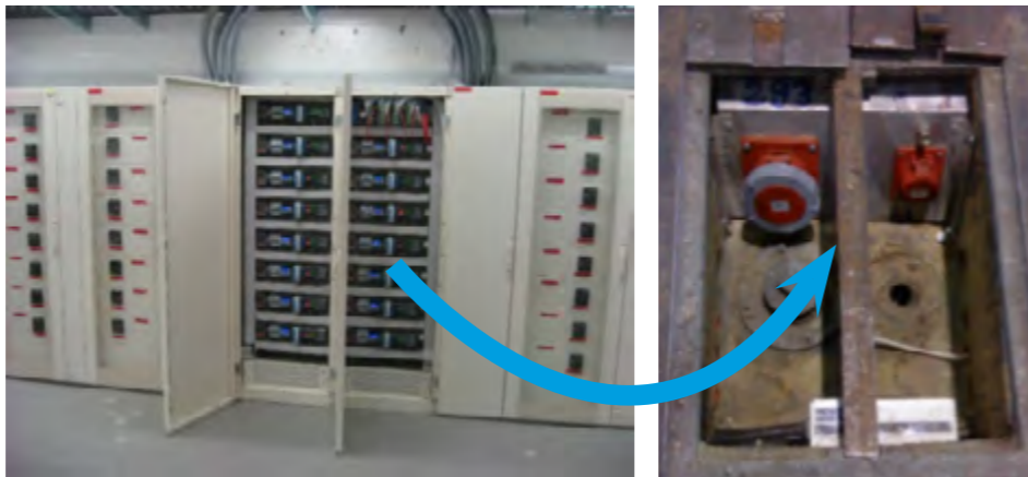
Beispiel PALEXPO GENF: Anschlusssteuerung CEE125A und 16A Typ 25.
